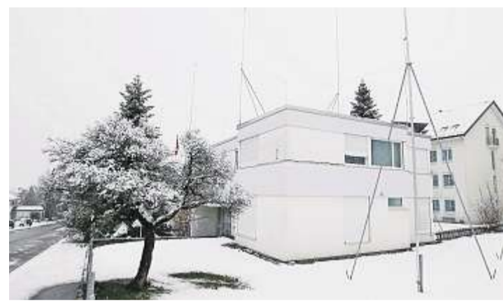
Anstelle des alten Pfarrhauses entsteht nun ein Wohnhaus. Madeleine Schoder
