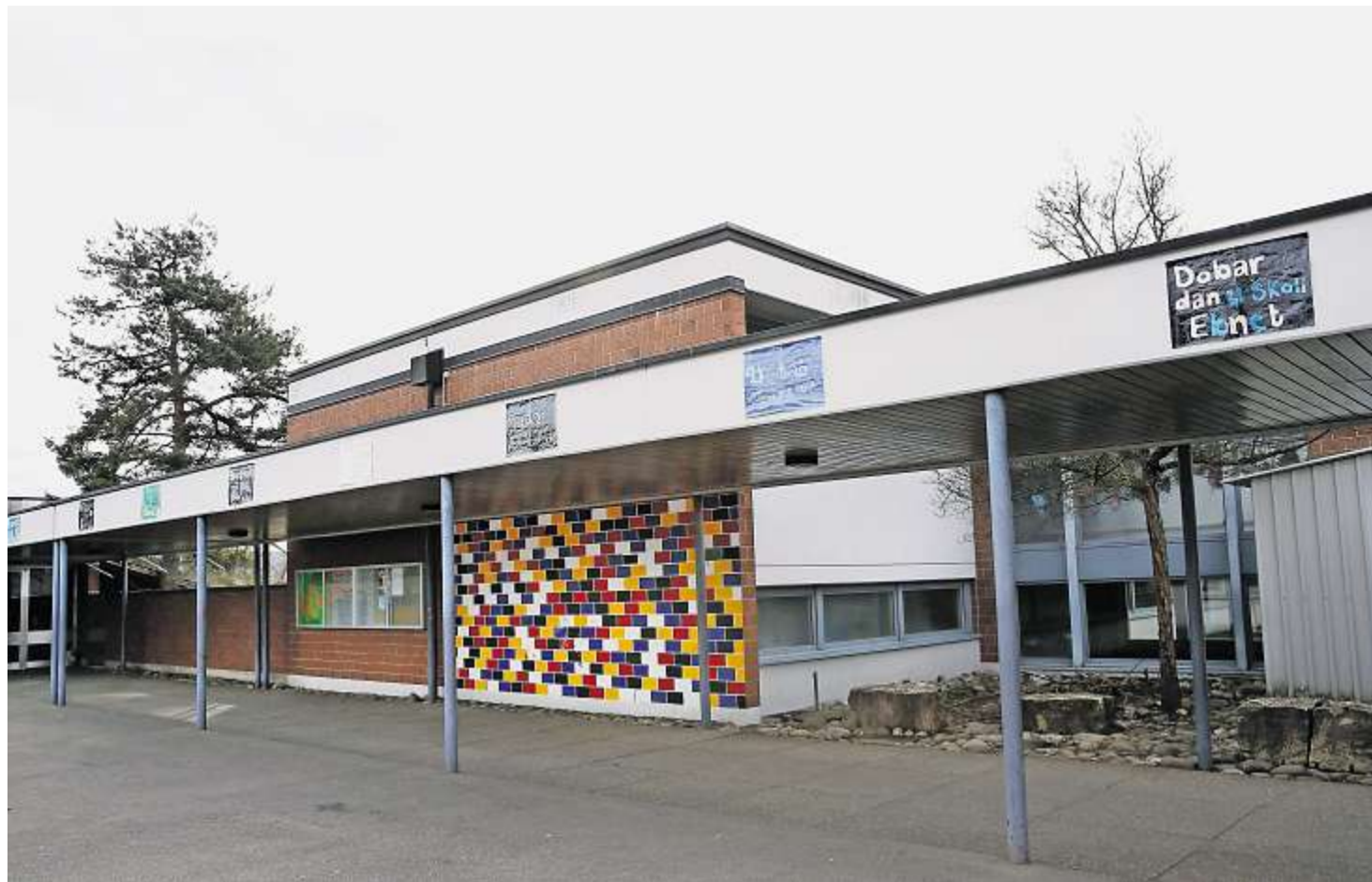
Die marode Schulanlage im Ebnet wartet schon seit Jahren darauf, dass sie endlich saniert wird. Ein erstes Sanierungsprojekt wurde 2013 wegen der hohen Kosten deutlich an der Urne abgelehnt. Archiv ZU
